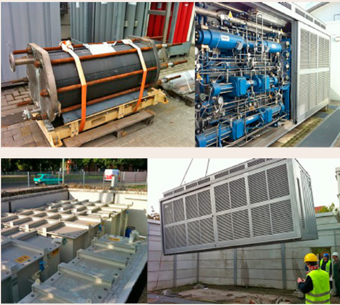
Bild 2: Rückbau von Elektrolyseur, Kompressor und H 2 -Speicher
