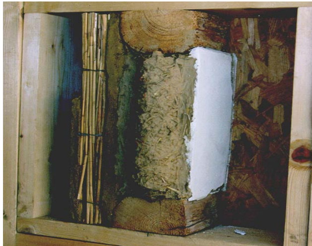
Abb. 1: Außenwandaufbau mit Edelputz, Lehm-Hackschnitzel-Ausfachung, Holzleichtbauplatte, Schilfrohrmatte
