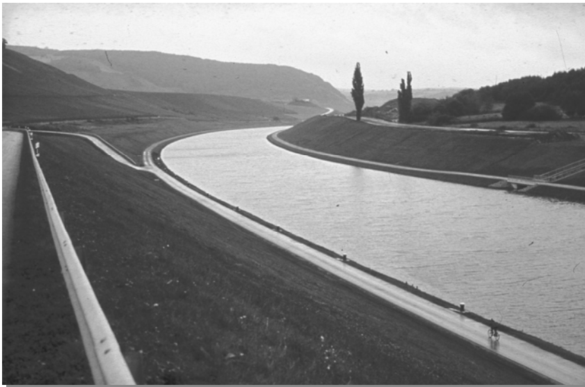
Abbildung 2: Massiv ausgebauter Flussabschnitt der Saar
